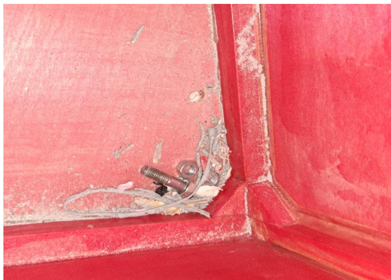
Obr. č. 11 spojovací čap s maticou
