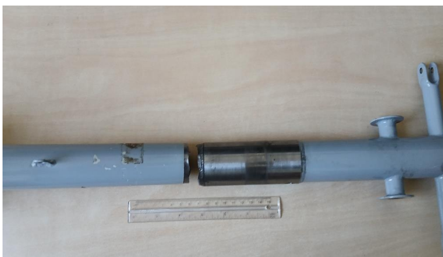
Obr. č. 6 Stojina PPN - miesto rozlomenia
